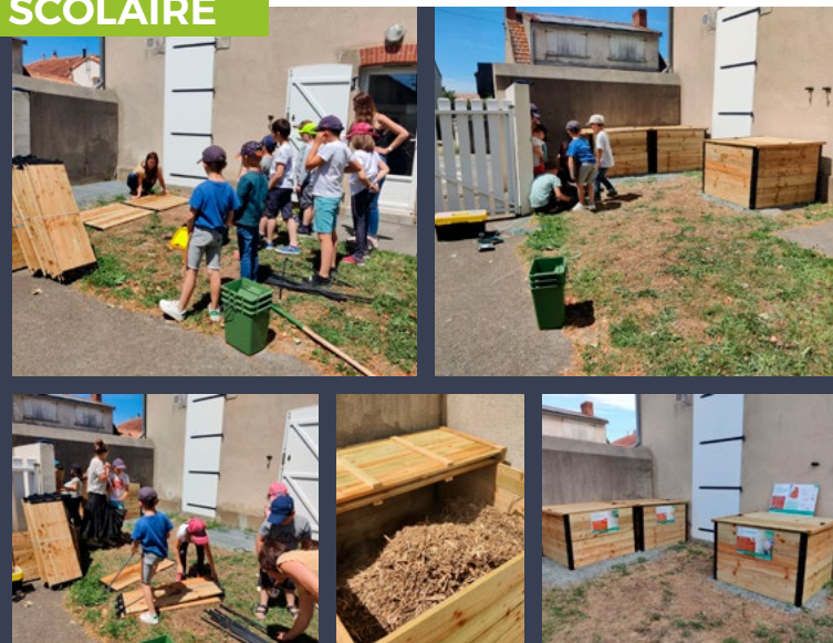
Montage et installation des composteurs pour le restaurant scolaire
