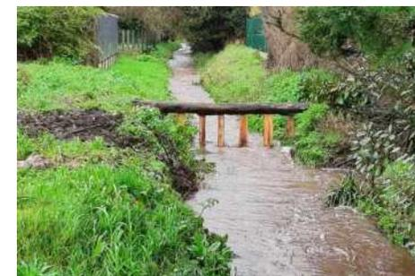
Principe de peigne à embâcles à réaliser Av des Dunes
