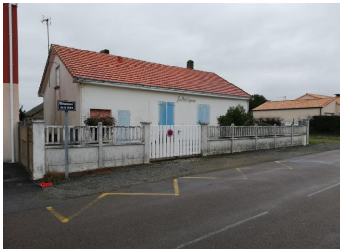
Arrêt existant au 28 boulevard de la Tara
